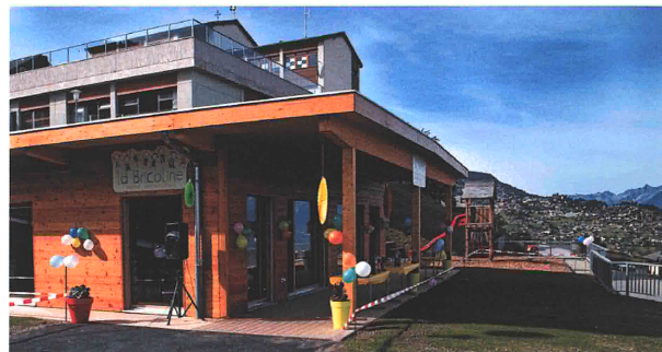
« La Bricoline » offre un espace d'accueil chaleureux, fonctionnel et lumineux pour les enfants de la région à quelques pas du centre scolaire de Veysonnaz.
