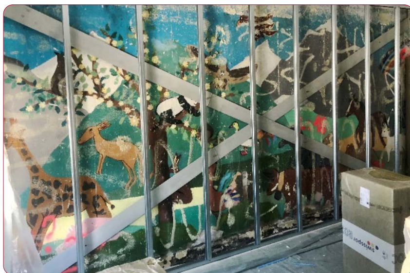
Croix de Saint-André boulonnées et intégrées aux parois Nord et Sud
